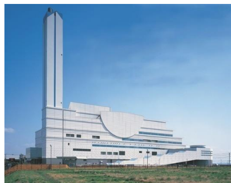
[ 新港清掃工場の全景 ]
