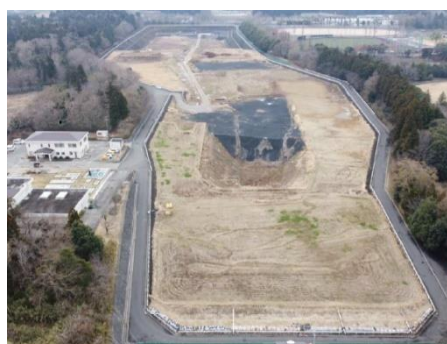
[ 新内陸最終処分場の全景 ]
