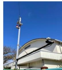
水路の注意水位で回転灯が点灯し、警戒水位で回転灯の点灯に加えて警報が吹鳴します。
