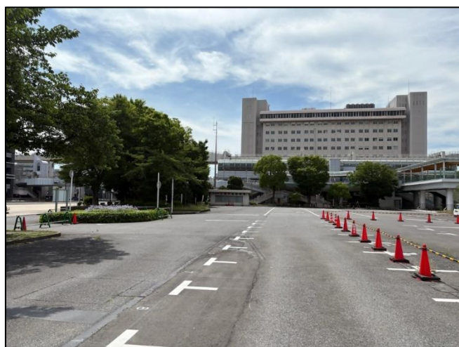
駐車場（検査場所）入口付近
