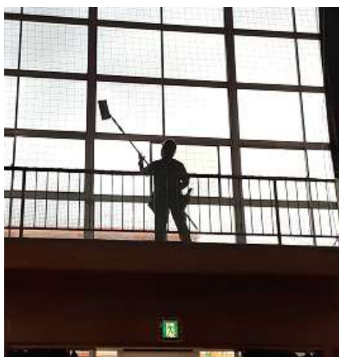
● ガラス清掃(体育館内側)
