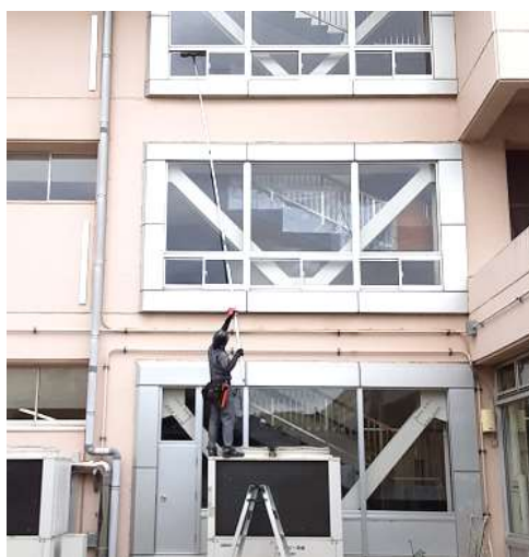
● ガラス清掃(本館外側)
