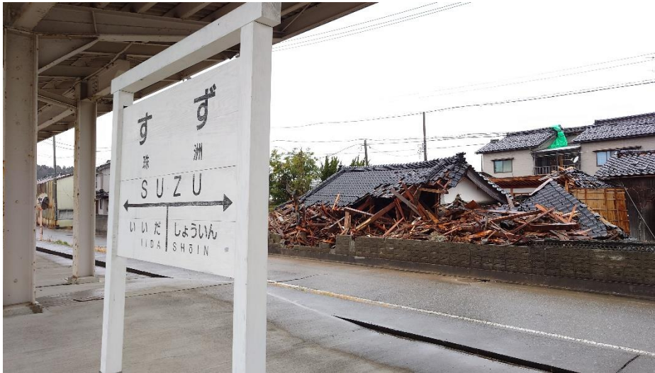
支援業務を行った珠洲市民図書館付近の被害
